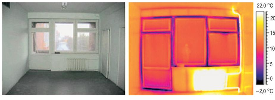
Рис. 3. Инфильтрация через неплотное примыкание створок окна и балконной двери
